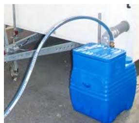
Fäkalienhebeanlagen müssen entleert und gereinigt zurückgegeben werden.
